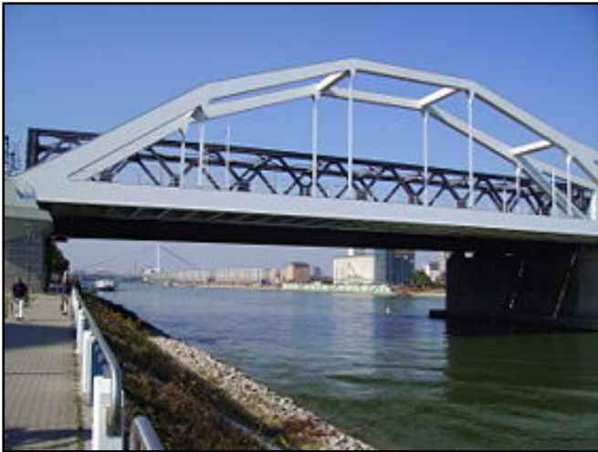
Puente fabricado de acero
